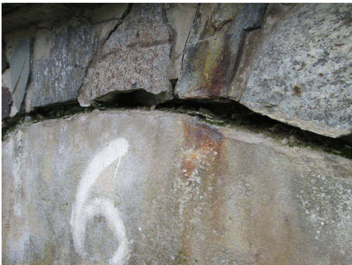
Levý bok NK – otevřená spára mezi NK a čelní zídrou, výluhy.
